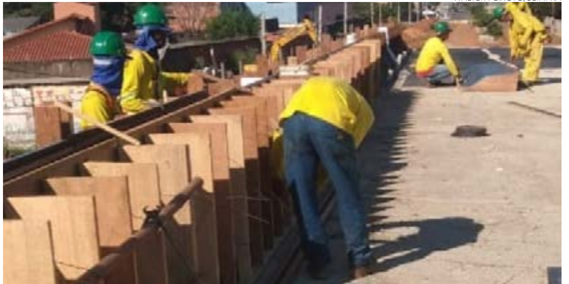
Avenida Castelo Branco será interdita hoje para obras no viaduto
